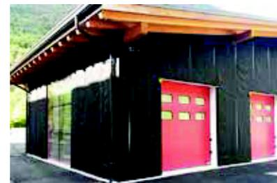
USB Tape UV applicato sulle giunture ed interruzioni della membrana traspirante USB Windtop UV garantisce la tenuta al vento della facciata ventilata
